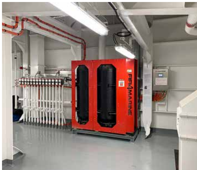
Schuimininstallatie van Fifi4Marine op een schip.
